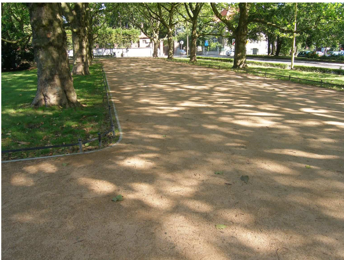
Fot. 13. Nawierzchnia PLAZADUR-tegra na Jasnych Błoniach w Szczecinie
